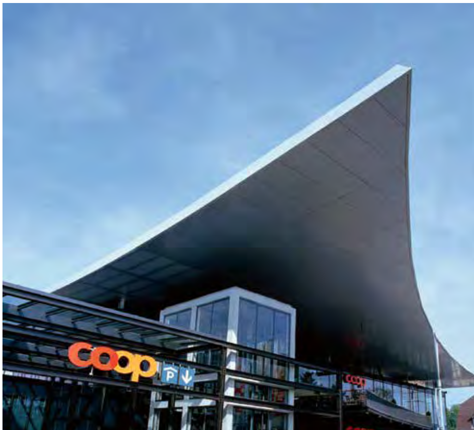
Прочность – большая, самонесущая крыша с облицовкой панелями ALUCORE®
